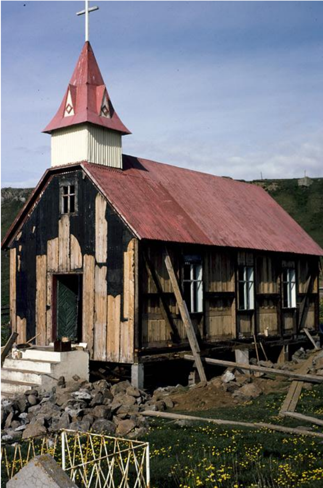
Mynd 10. Framkvæmdir við Skarðskirkju 9. júlí 1981. Vesturgafli og suðurhlið kirkjunnar. Ytri klæðning hefur verið fjarlægð og steiptir burðarstöplar komnir undir kirkjuna Ljósmynd Guðmundur Ólafsson (Skg.-4967).
