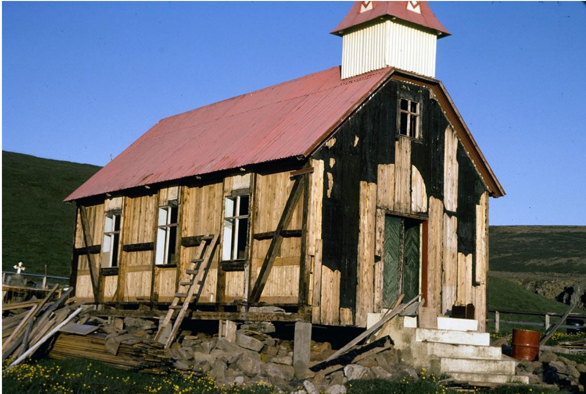
Mynd 1. Viðgerð á Skarðskirkju sumarið 1981. Vesturgafli, kirkjutröppur og norðurhlið kirkjunnar. Búið er að steypa undirstöðustöpla undir kirkjuna. Gröfin kom í ljós við austurgafli kirkjunnar. Ljósmynd Guðmundur Ólafsson (Skg.-4966).
